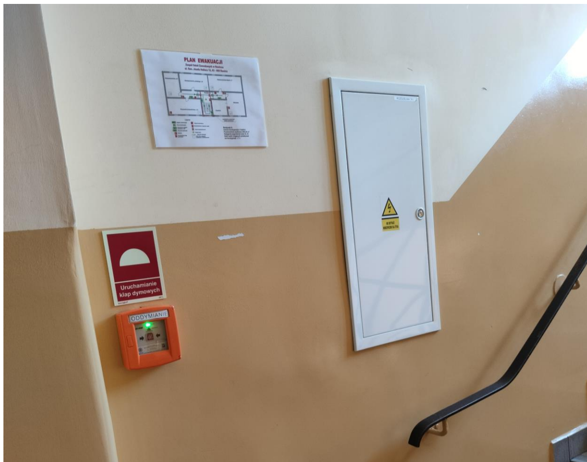
Rysunek 1. Istniejąca rozdzielnica zlokalizowana na korytarzu budynku - do demontażu.
